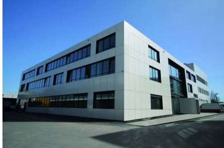
Reinraumprüfzentrum am Fraunhofer IPA
